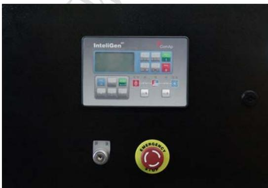
自动化并机机组控制屏通过对发电机组各种参数的采集以及机组之间的通讯,根据用户设置的值进行自动高速计算,对机组的电压、频率、相位角自动进行调整并达到同步、自动合闸并机。然后对机组及机组之间进行有功及无功功率管理和协调整套系统内机组加减控制。具有全自动全过程电脑数字控制,机组具有自动起动,自动同步并机、自动负载分配、并机自动装卸载、逆功保护、机组各种故障保护、负载过载保护、带有柔性加减负荷功能,减少对机组的冲击,系统可以同时管理 32 台发电机组并网。
